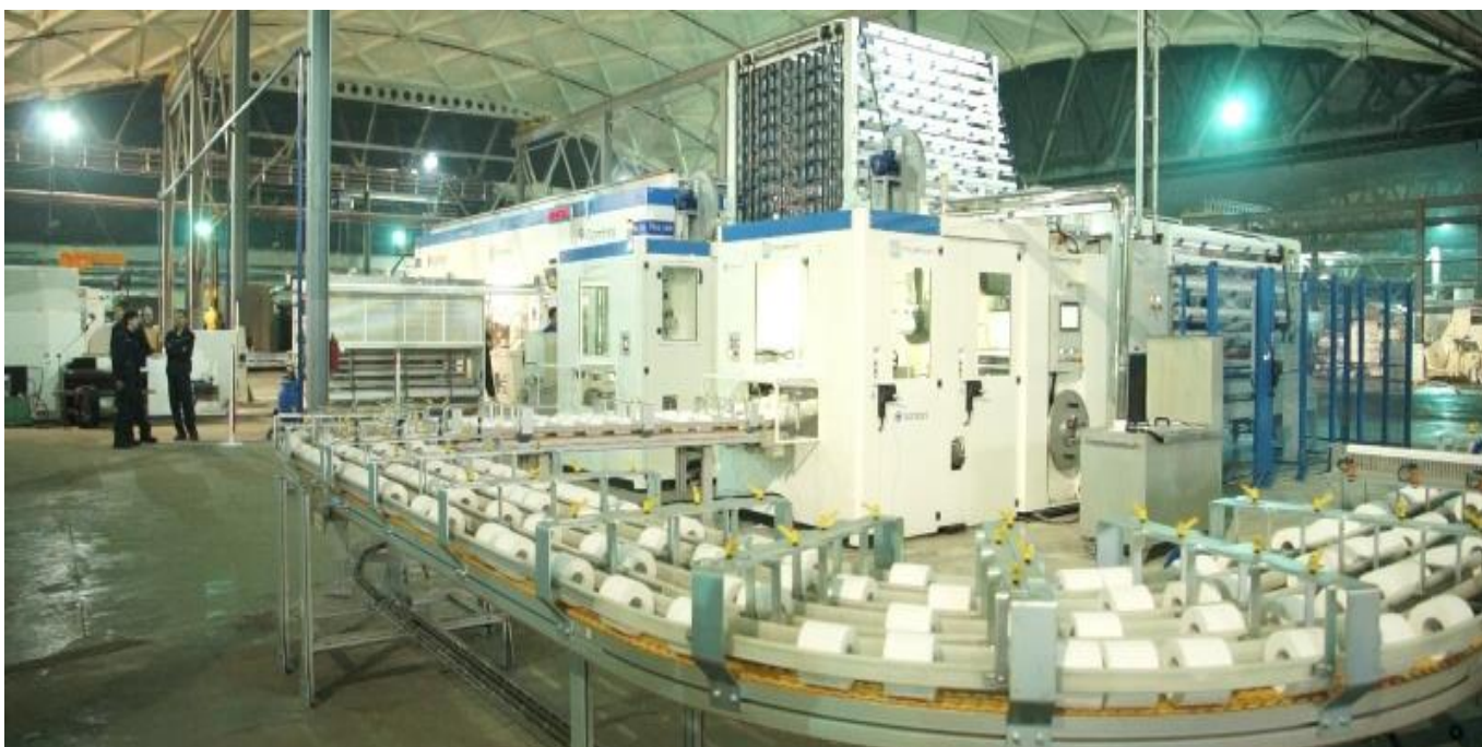
Линия по производству санитарно-гигиенической продукции ОАО «Сясьский ЦБК»
