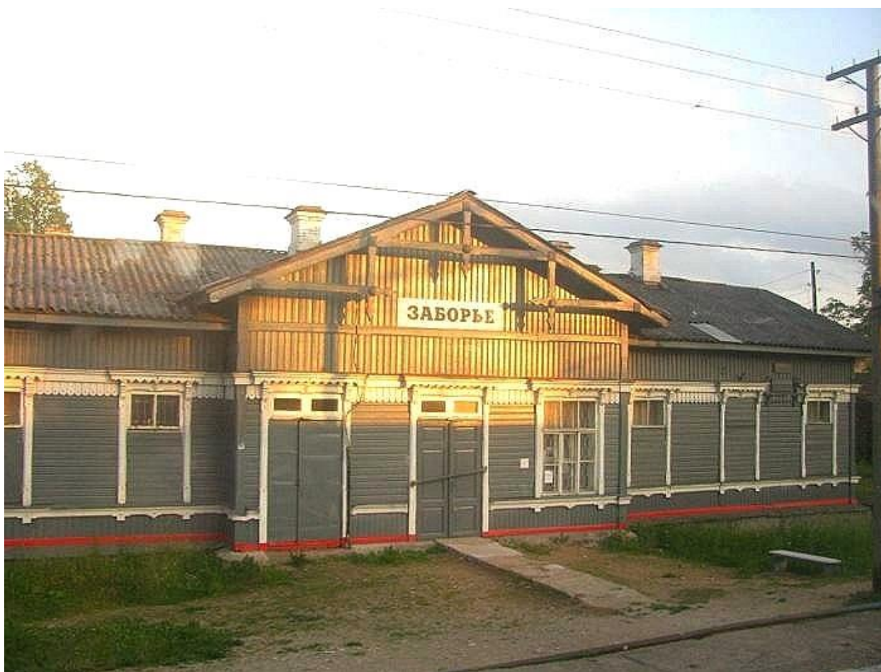
Рисунок 15. Железнодорожная станция Заборье, Бокситогорский район.
